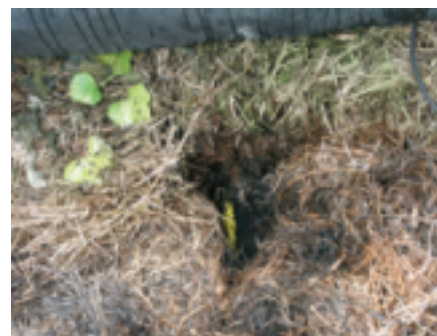
Dahn gräver och gräver i det skyddande och isolerande halmlagret för att komma ner till den slang som släpper ut det förorenade vattnet högst upp i reningsverket. När vattnet silats igenom materialet och bakterierna gjort sitt pumpas det reade vattnet ut i det kommunala avloppssystemet.
