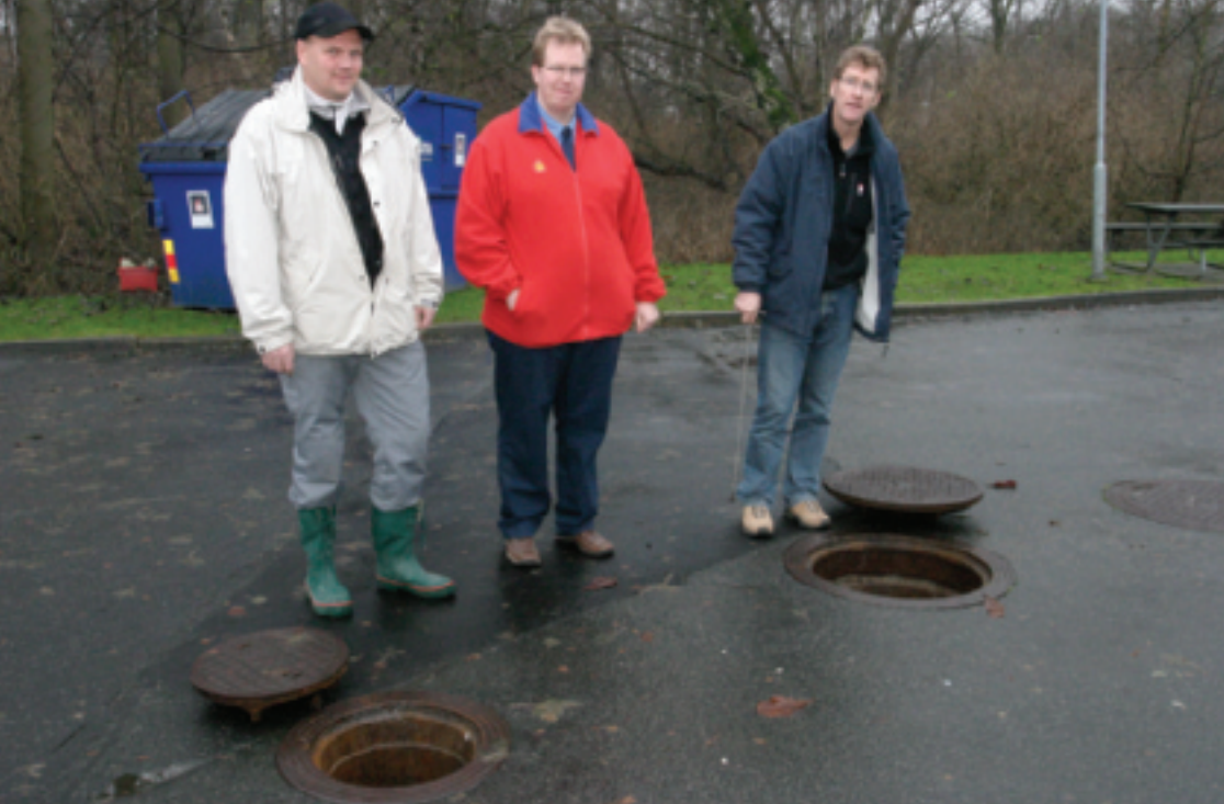
Thomas, Mattias och Dahn står på den enda yta som behövs grävas upp för att lägga slang mellan brunnar och reningsverk.
